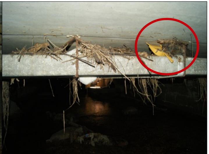
Gaines en hauteur avec dépôts des inondations
