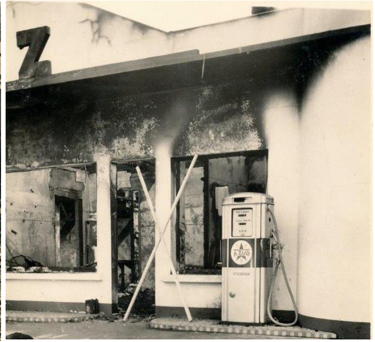
Les dégâts dans le bureau et les appartements
