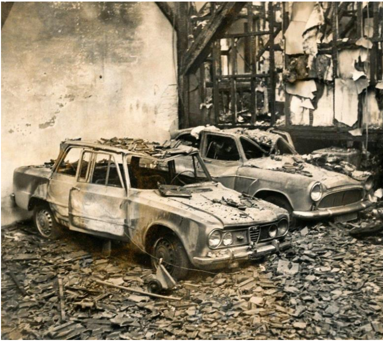
Les dégâts dans le garage
