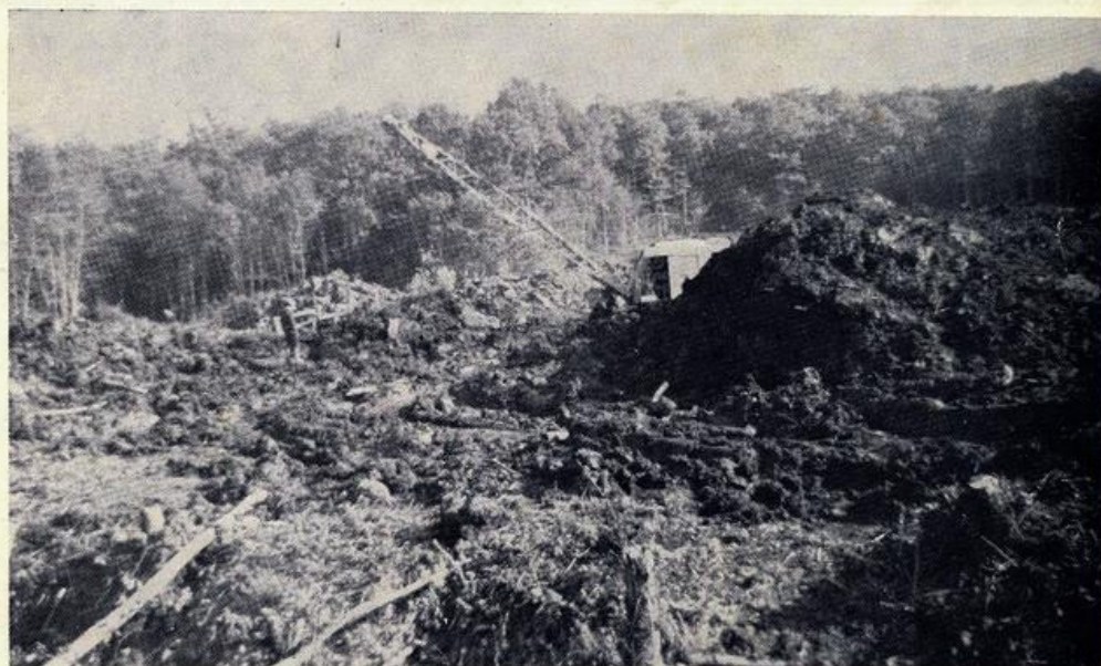
Le lac de Contrexeville en cours d'aménagement.
