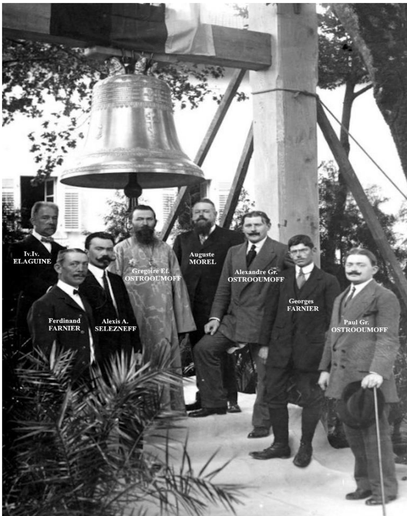
La structure de la chapelle ne pouvant supporter le poids de la cloche qui pèse 842 kilos, celle-ci a été placée sous un portique à l'extérieur.
