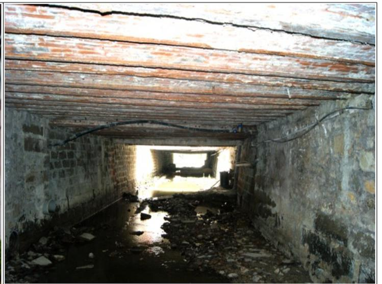
Après être passé sous une dalle de béton armé, une grande brèche nous rappelle la fragilité de l'autre couverture qui forme le plafond du ruisseau canalisé jusqu'à sa confluence avec le Vair dans le parc, des fers en T supportent une forme arrondie constituée de briques. Cette couverture date de 1895, car le ruisseau de Suriauville a été recouvert bien avant le Vair (1907).
